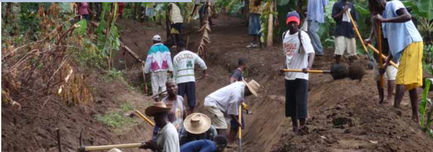
Les activités de réhabilitation des infrastructures agricoles contribuent à renforcer les moyens de subsistance ruraux et à participer à la prévention des catastrophes (ici curetage de canaux) © ACTED 2011
