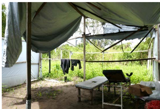
Une partie des bâches qui recouvraient le Centre de traitement du choléra de Kabeya ont été volées, exposant les patients aux intempéries. ©OCHA/A. Rime
