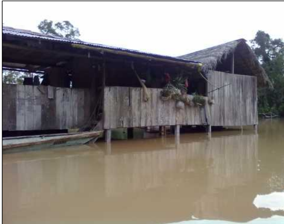
INUNDACIONES DE VIVIENDAS DE LA ZONA RURAL DEL CANTON
