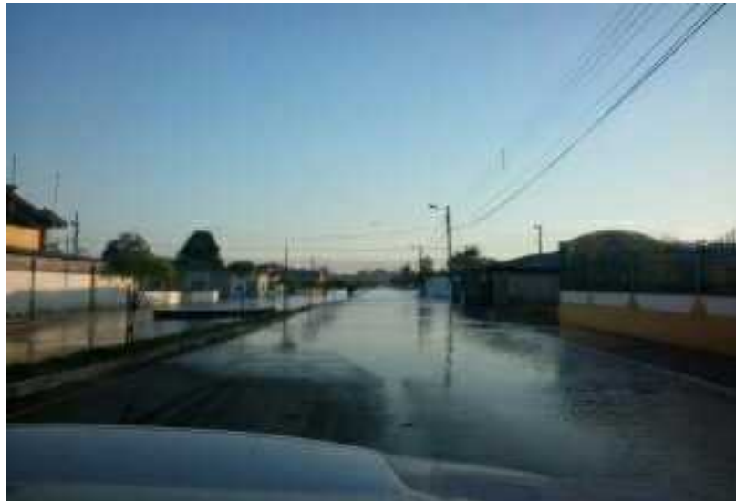
INUNDACIÓN DE LA ZONA URBANA DE LA PARROQUIA (CALLES ALEDAÑAS AL SUBCENTRO DE SALUD)
