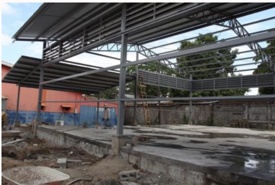
Personal de SINAPRED y PMA supervisan la construcción de la bodega.
