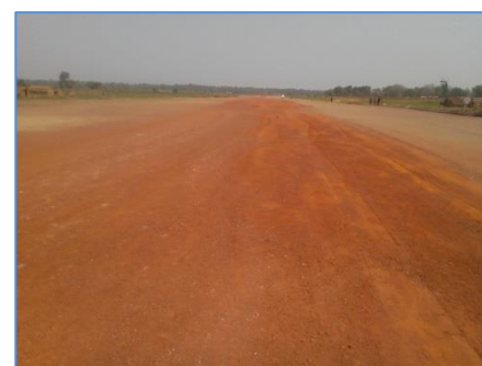
©UNHAS. Kaga Bandoro, Préfecture de la Nana Gribizi – Piste de l'aérodrome rénové.
