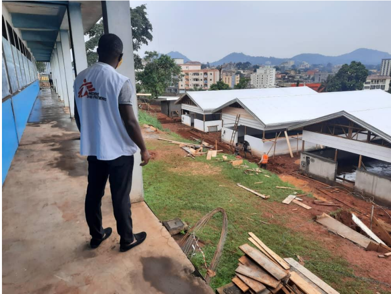
Construction de 4 salles à l'hôpital de Djoungolo pour la prise en charge des patients de COVID 19 à Yaoundé ©Nicole Fouda/MSF
