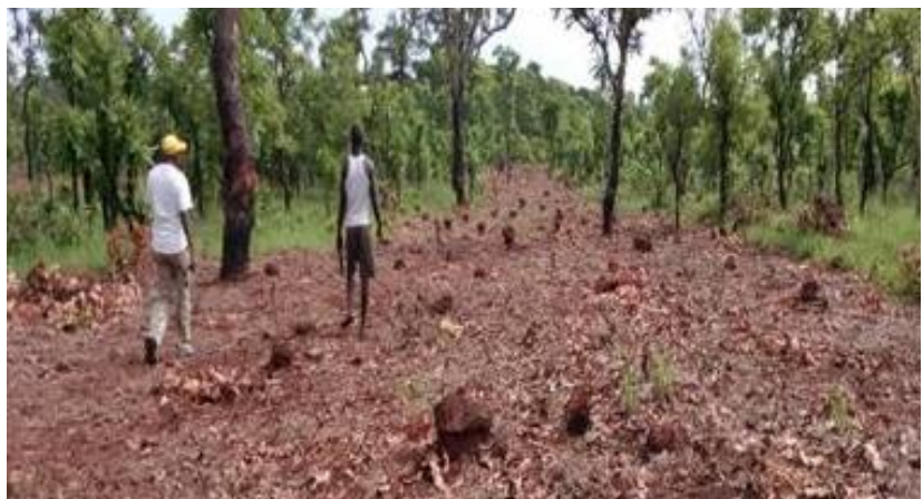
Préparation du terrain pour la construction des abris transitionnels pour les réfugiés à Ndu, territoire de Bondo, province de Bas-Uele © UNHCR/N. Gergely
