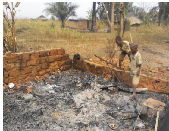
Photo 1: Maison incendiée durant le conflit, à Dibaya
