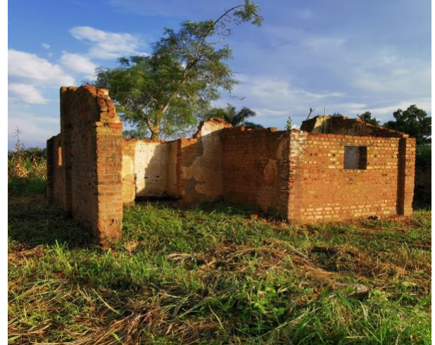
Photo 2: Bâtiment annexe de la mairie de Tshimbulu
