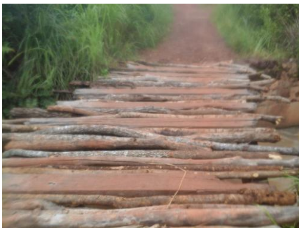
Pont sur l'axe Grimari – Mala, après installation manuelle et temporaire de planches
