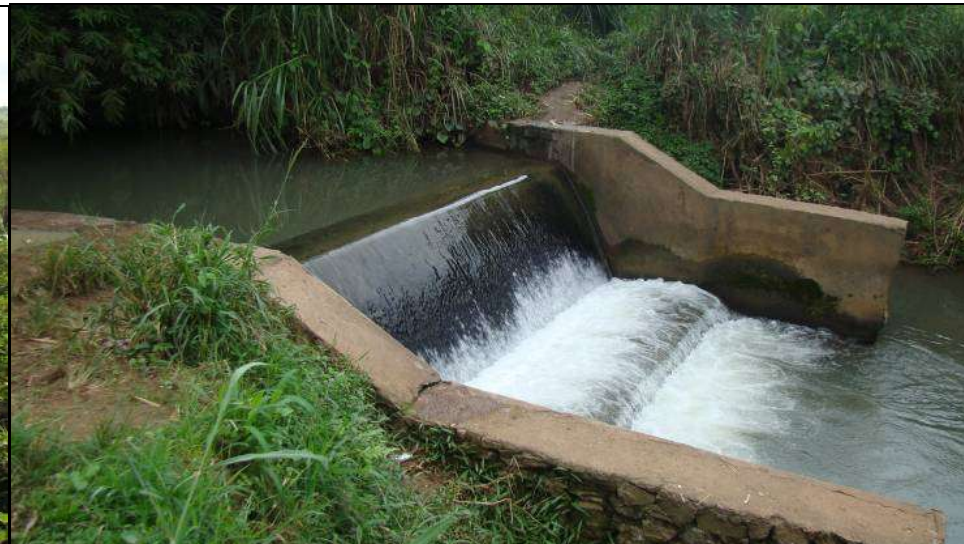
Bassin de rétention d'eau avec canalisations bouchées à Mvuazi
